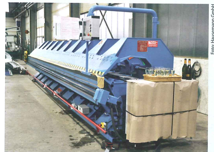
Der Maschinentausch ist erledigt, jetzt noch fixieren, einstellen, sichern ...
