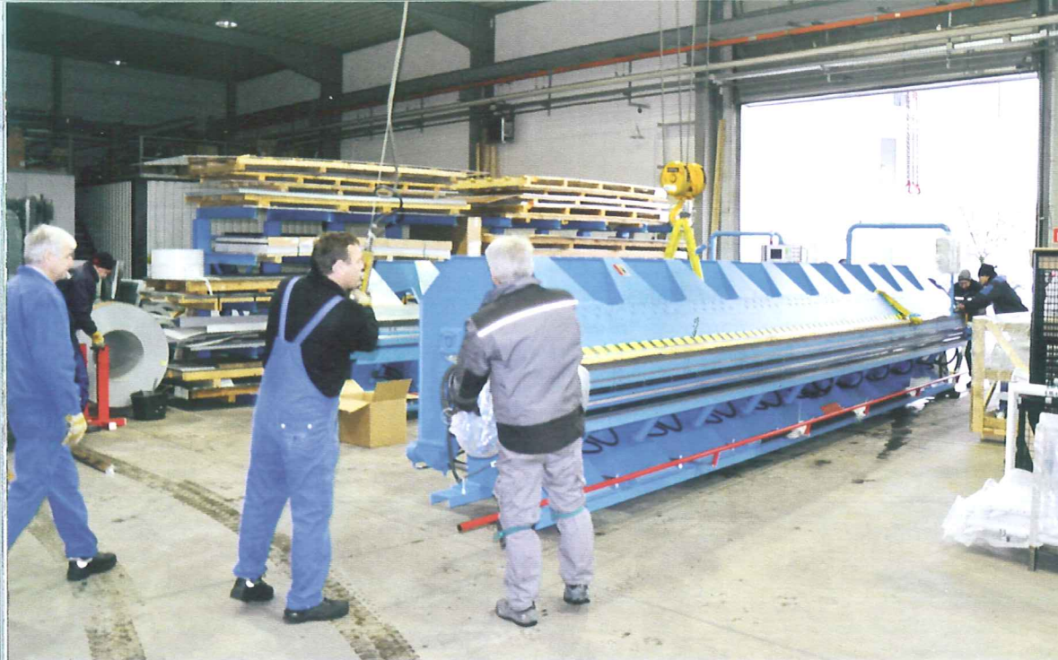
Die alte Biegemaschine steht für den Abtransport bereit, während die neue Superline Highspeed langsam einschwebt.
