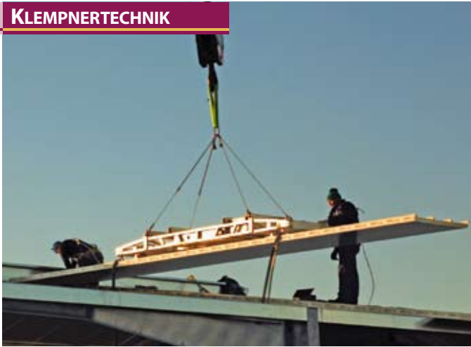
Mit dem Hebegerät werden Profilbahnen, Trapezbleche oder Sandwichelemente ohne Zwischenlager in die Endposition aufgelegt.
